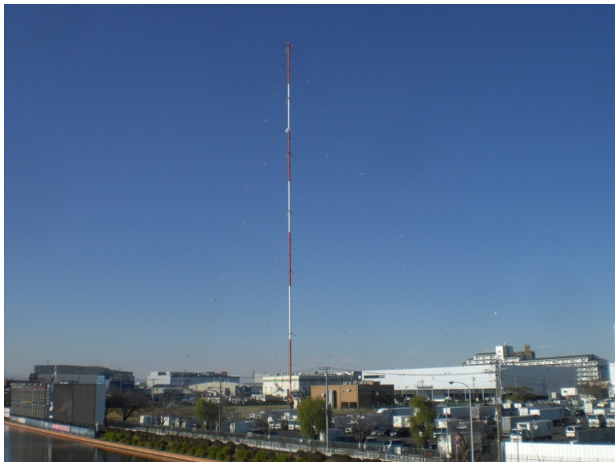
大出力送信所の例 (出力100kW、送信アンテナ高150m。右下の茶色の建物が局舎。)
