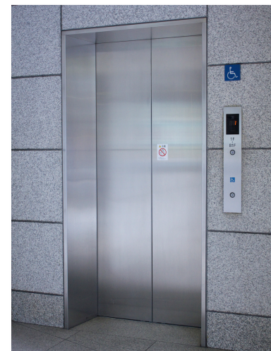
エレベーター (管理通信用モジュール)
