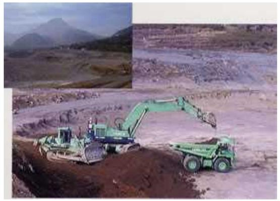
遠隔作業中のブルドーザ、パワーショベル、大型ダンプ
