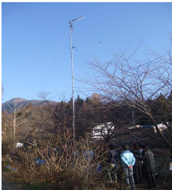
(I) 第1GFの送信点全景
