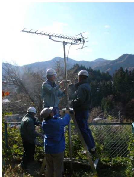
(C) 第1GFの受信アンテナ工事風景
