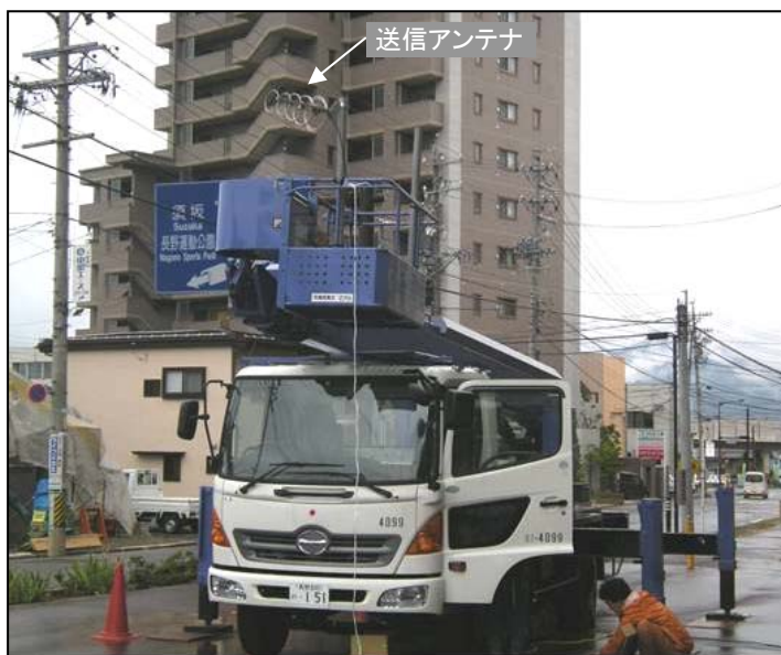
(A) 送信アンテナ設置バケット車
