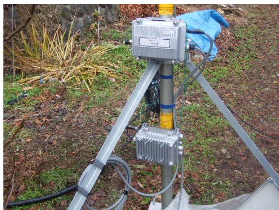
(L) 第1GFの送信機 (上が第1送信機、下が第2送信機)
