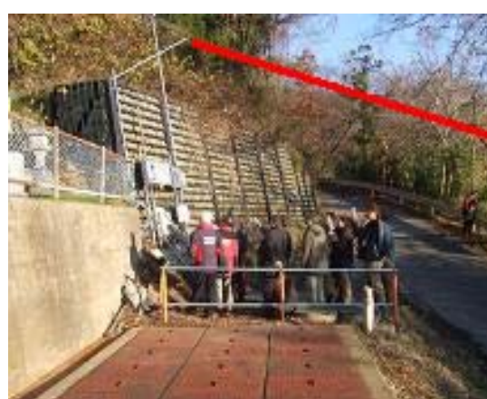
(H) 第1GFの光ファイバー等の設置状況 (赤線で示した部分)
