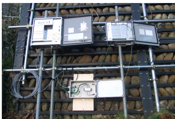
(E) 第1GFの受信設備
