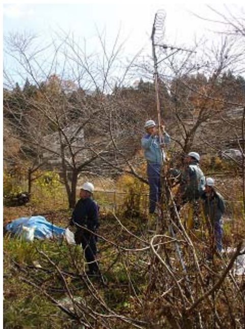
(J) 第1GFの送信アンテナ工事風景
