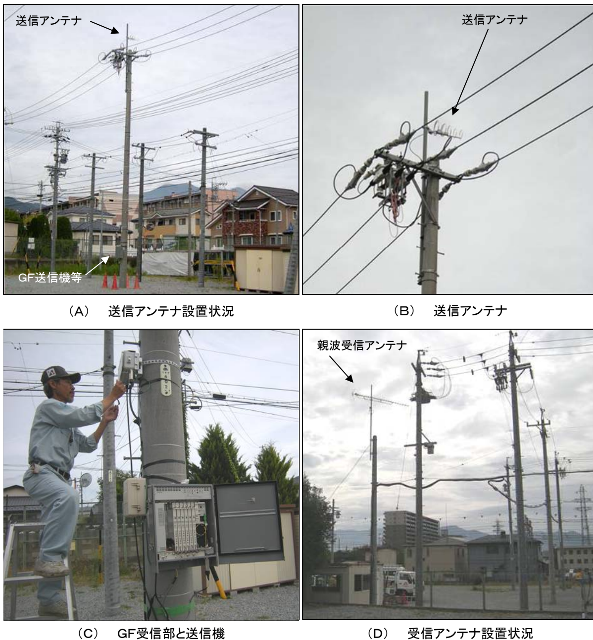
図2. 1. 3. 2. 1 第2GF設置状況
