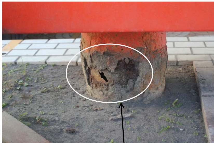
ポスト支柱が腐食し 穴が生じている
