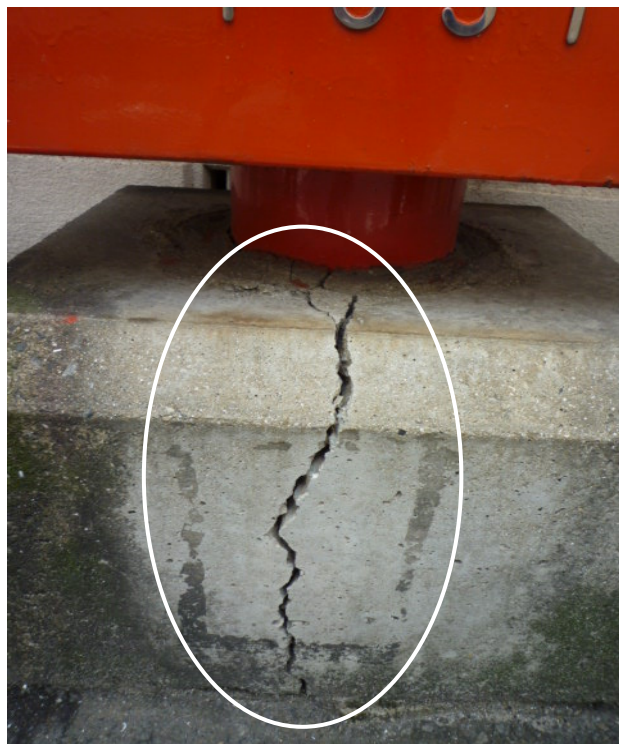
台座の中央部が縦方向にひび割れ
