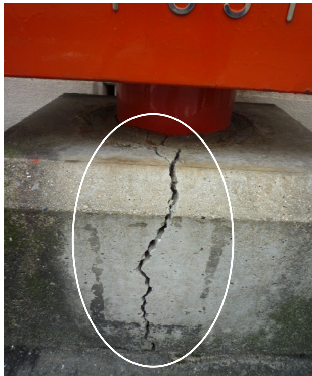
台座の中央部が縦方向にひび割れ
