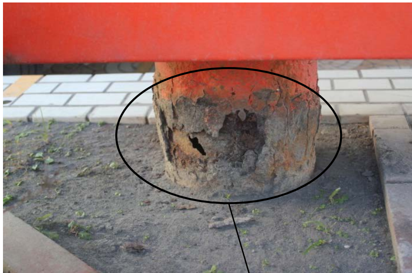
ポストの支柱が腐食して穴が生じている。
