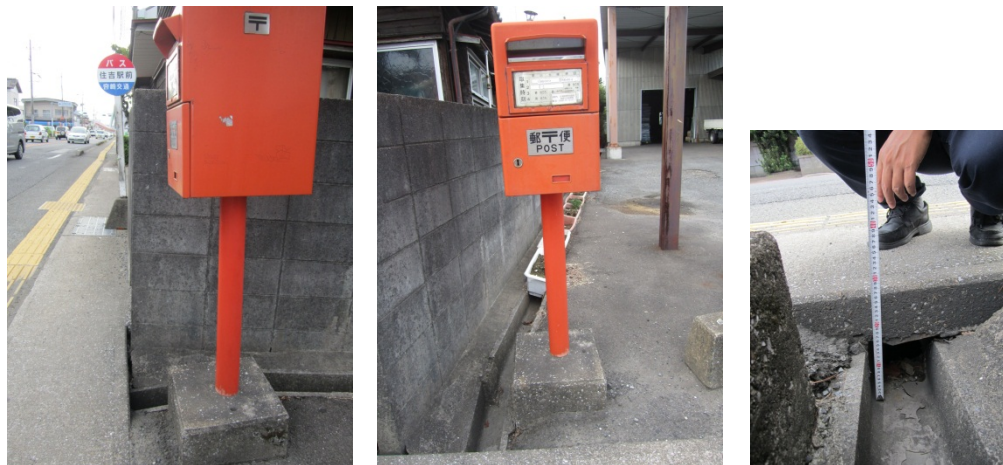
郵便ポスト正面とその前方の歩道との間には、幅16 c m、深さ13 c mの隙間があり、また、当該隙間の下 (郵便ポストに向かって左下) には幅15 c m、深さ15 c mの溝がある
