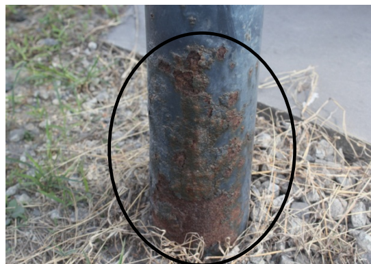
支柱の根元が腐食
