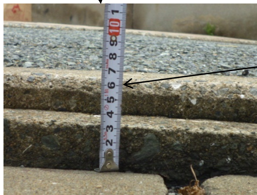
車道（路側帯）から歩道部分への段差は6cm
