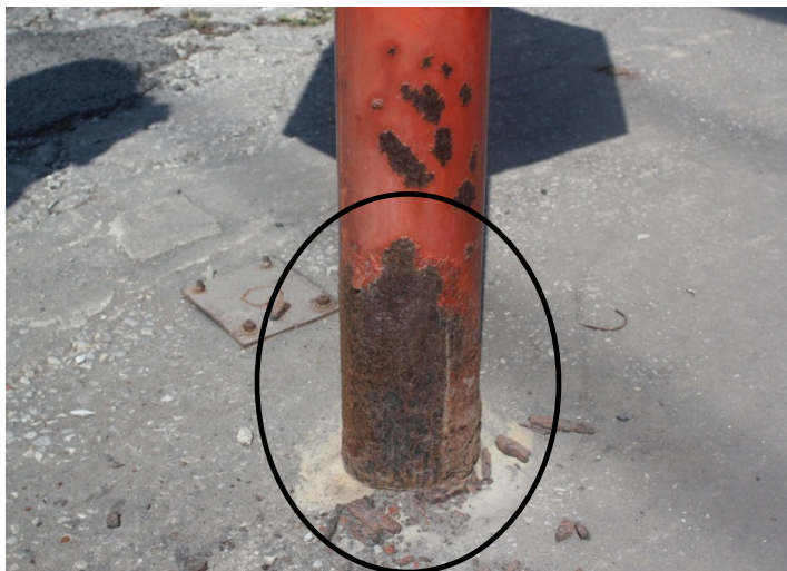
支柱の根元が腐食
