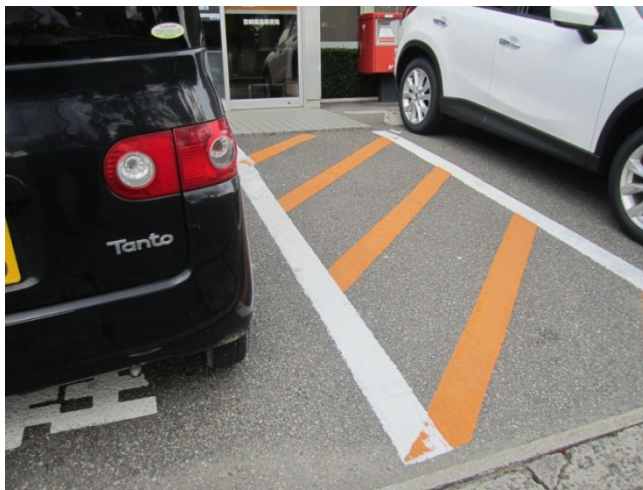
宮崎霧島郵便局敷地外から郵便ポストまでの高さが16cm以上 敷地外から郵便局敷地内にある郵便ポストへ続く通路の勾配は6～10度
