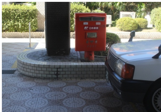
ポストの支柱が腐食して穴が生じている。
