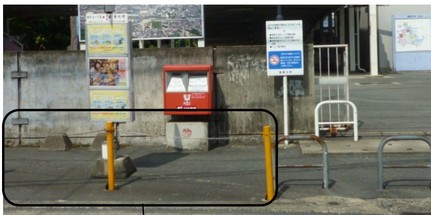
車両の進入を防止するための柵 (支柱の間に鎖あり)
