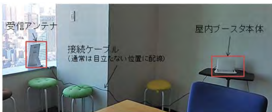
図 2-2 屋内ブースタ設置例
