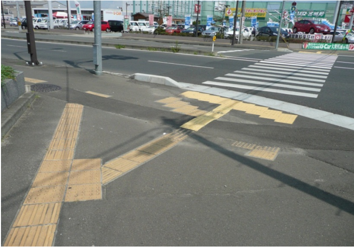
事例9 (誘導用ブロックが適切に設置されていないもの)
