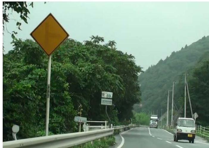
事例2 (警戒標識の表示が消えているもの)
