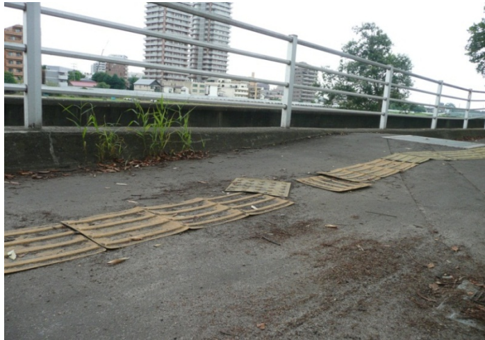
事例11 (誘導用ブロックが破損しているもの)
