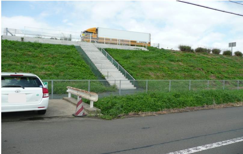
事例20 (津波避難階段の上り口の側溝に蓋が無いもの)
