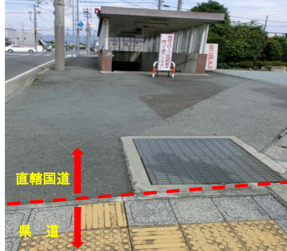
事例10 (直轄国道と県道との連続した誘導用ブロックが設置されていないもの)
