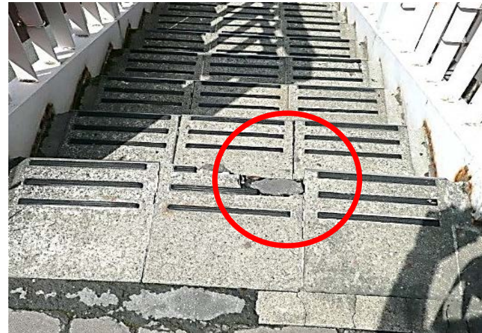
事例15 (横断歩道橋の階段(段鼻)が破損しているもの)
