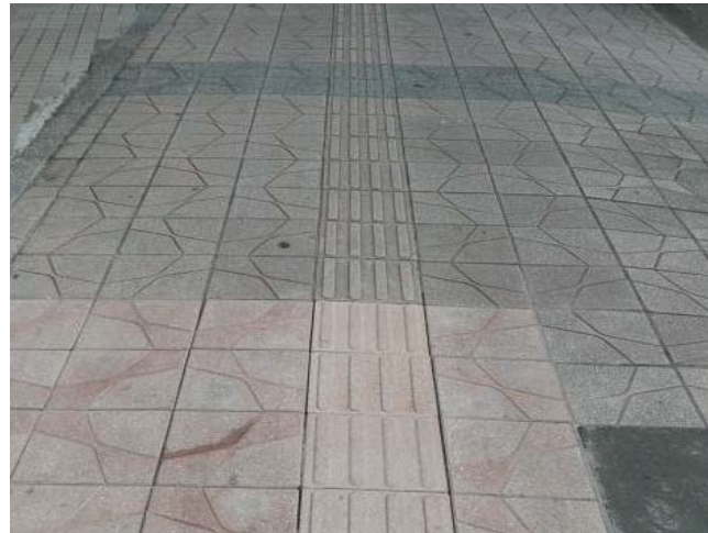
事例12 (誘導用ブロックが容易に識別できないもの)
