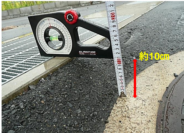
事例6 (歩道中央に約10cmの段差が生じているもの)
