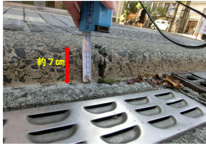
事例7 (歩道と車道の上に約7cmの段差があるもの)
