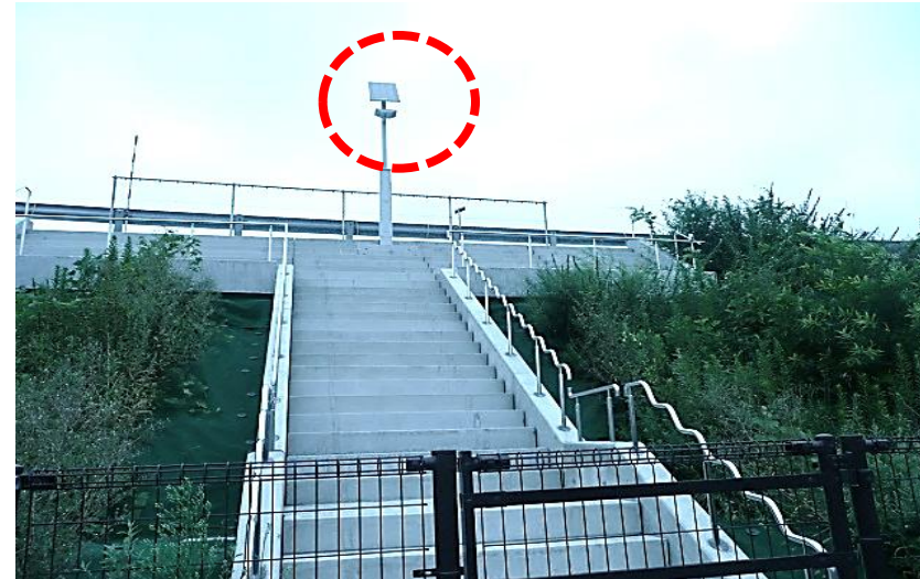
参考 (ソーラーにより稼働する誘導灯の例)
