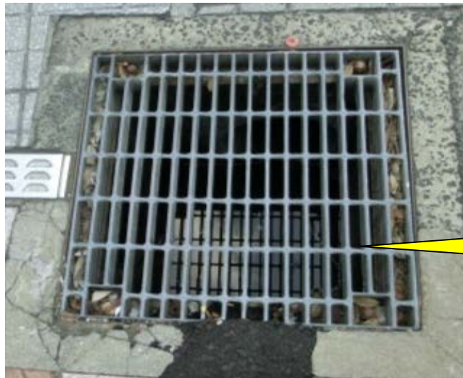
事例5 (排水溝の溝幅が広く、車いすの車輪が挟まれるおそれがあるもの)
