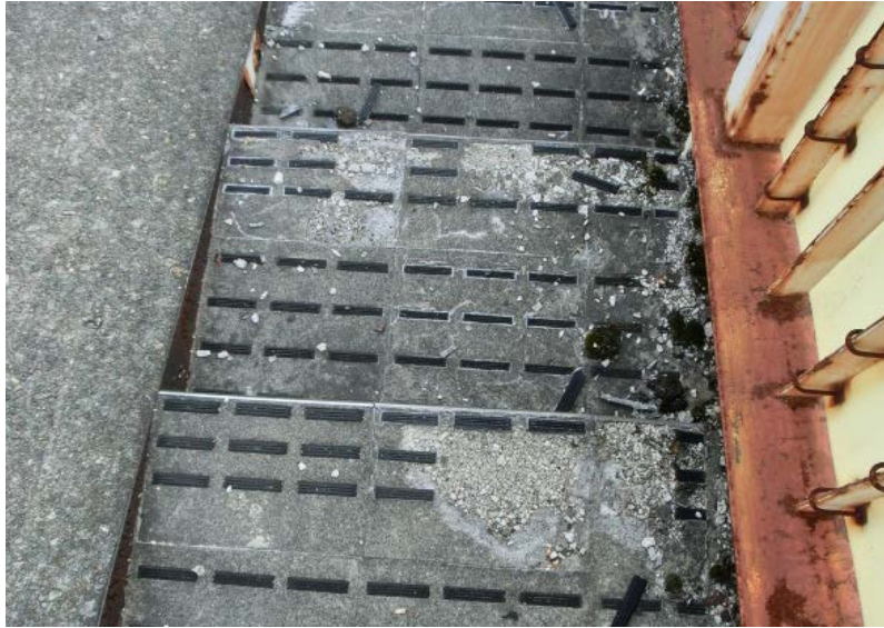
事例15 (主桁が腐食し、穴が空いているもの)
