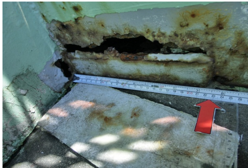
事例15 (主桁が腐食し、穴が空いているもの)
