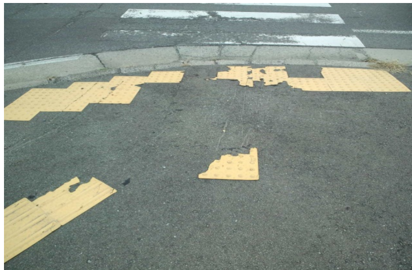
事例9 (破損し、途切れているもの:横断歩道手前)
