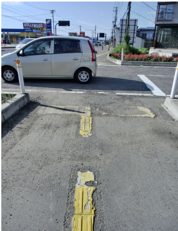
事例7 (破損し、途切れているもの:交差点手前)
