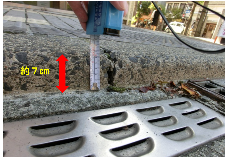
事例5 (排水溝の溝幅が広く、車いすの車輪が挟まれるおそれがあるもの)
