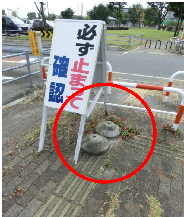
事例17 (誘導用ブロックに看板等の障害物が置かれているもの)
