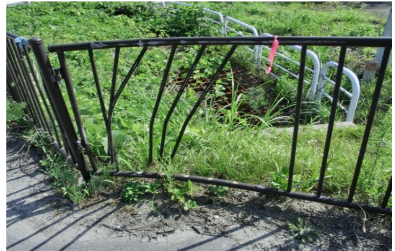
事例6 (防護柵が壊れており、歩行者が転落するおそれがあるもの)
