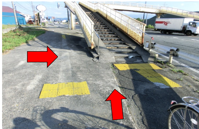
事例9 (破損し、途切れているもの:横断歩道手前)
