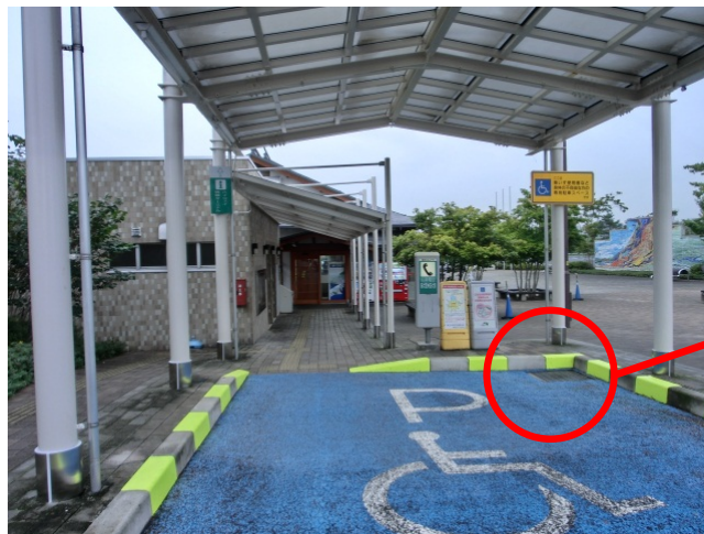
事例19(障がい者用駐車施設の排水溝の溝幅が広く、車いすの車輪が挟まれるおそれがあるもの)
