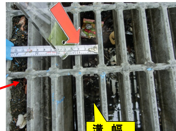
事例19(障がい者用駐車施設の排水溝の溝幅が広く、車いすの車輪が挟まれるおそれがあるもの)
