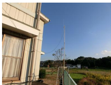
屋外ダイポールアンテナ(送信場所方向)
