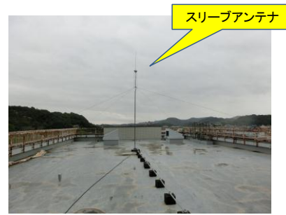
市役所屋上送信アンテナ
