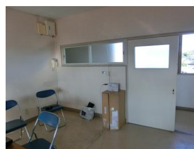
ロッドアンテナ建屋内部(QPSK)
