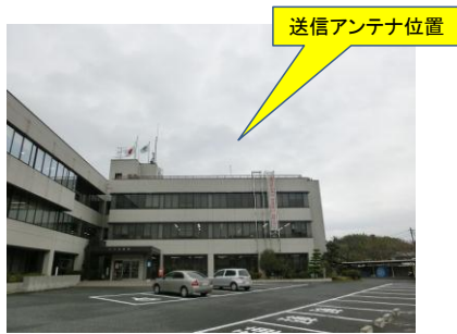
市役所屋上送信アンテナ
