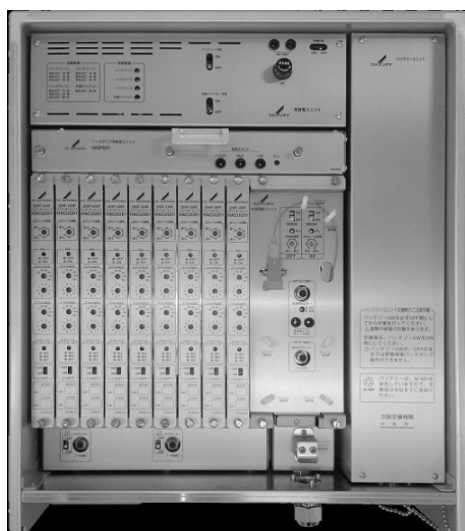
受賞を受けた可搬型緊急用ヘッドエンド装置
