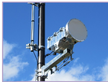
23GHz帯無線伝送装置屋外設置
