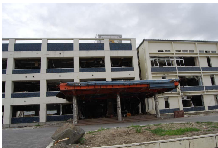
被災した陸前高田市役所（2011年7月22日）
