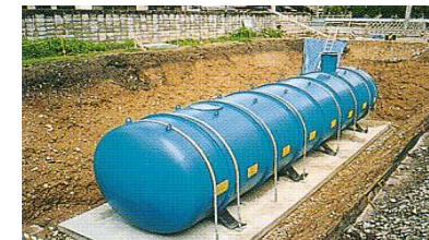
耐震性貯水槽※
