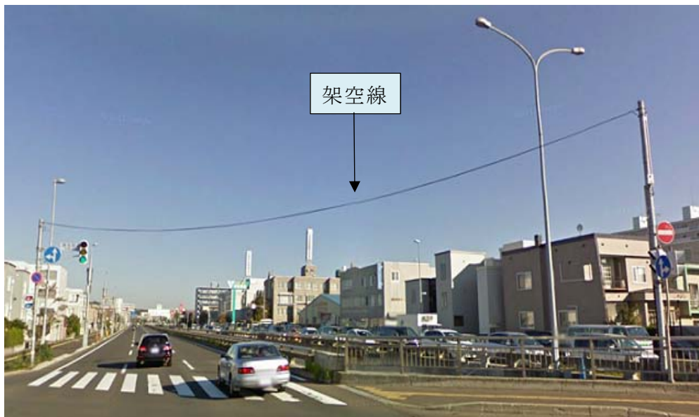
(平成 26 年 5 月 29 日現地確認)
