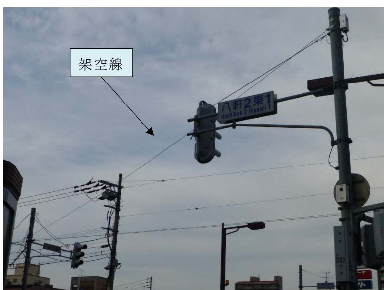
（平成 26 年 4 月 30 日現地確認）
