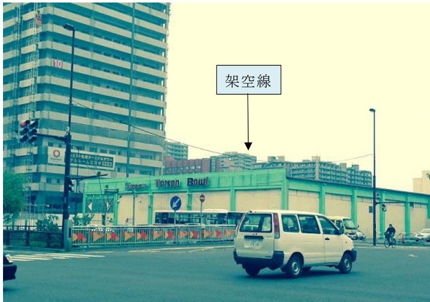
(平成 26 年 5 月 15 日 現地確認)
