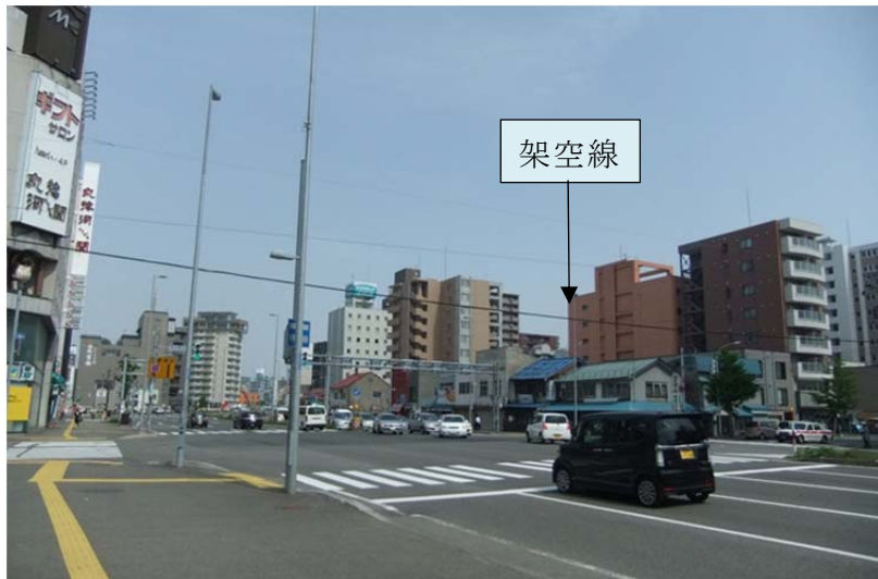
（平成26年5月19日現地確認）
