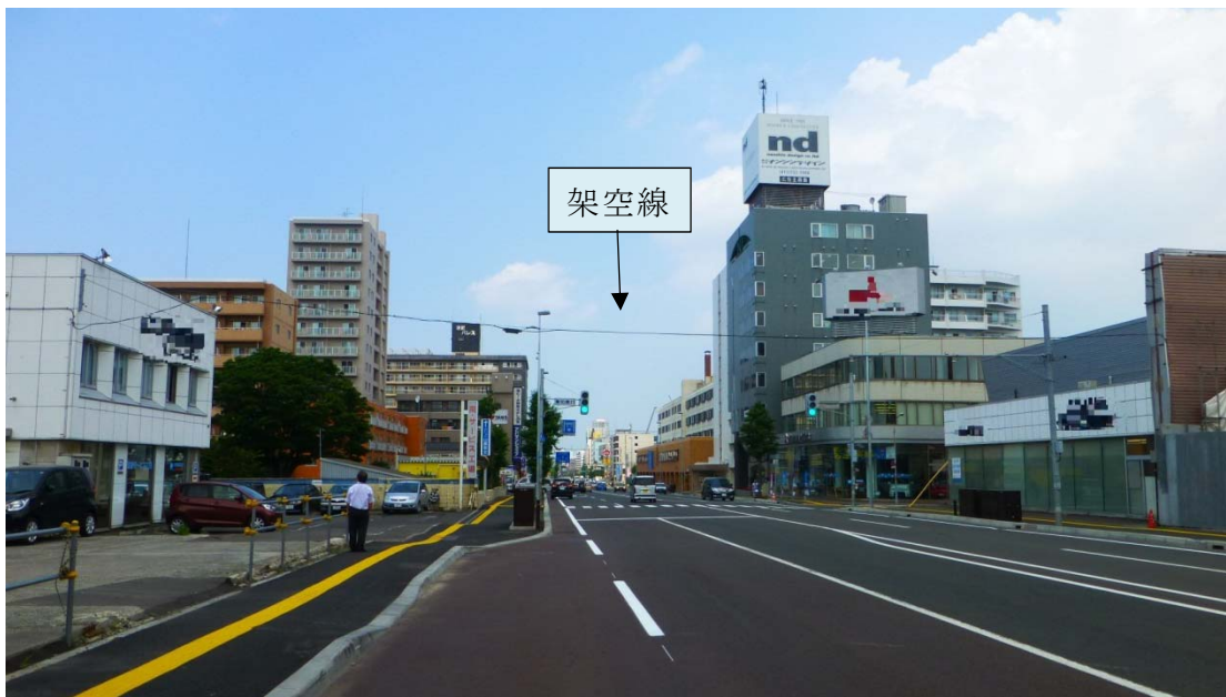
(平成26年5月29日現地確認)
