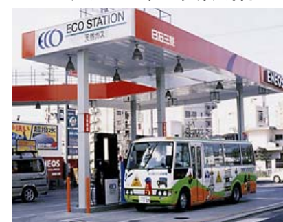
天然ガス充填設備
