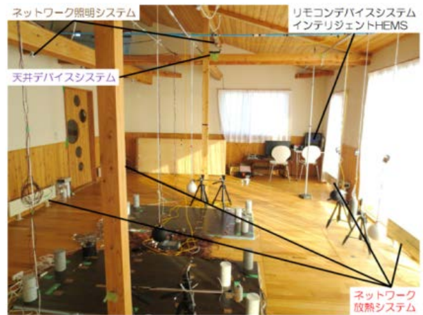
図 1 アクティブ室内環境制御システムの構築状況
