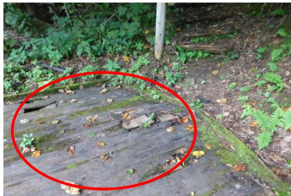
川遊び広場のバリアフリー散策路が一部破損している (2か所)。
