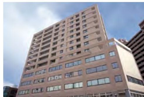
建物外観(3階が支援センター)
