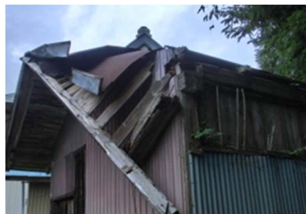
↑ 屋根が傾斜、損傷が大きい
