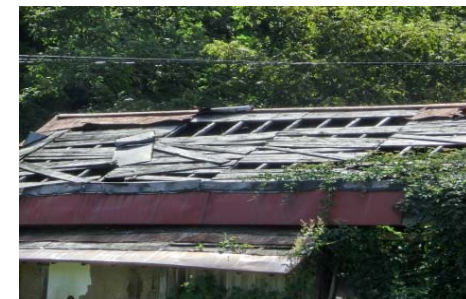
↑ 半壊した屋根材が飛散のおそれ
