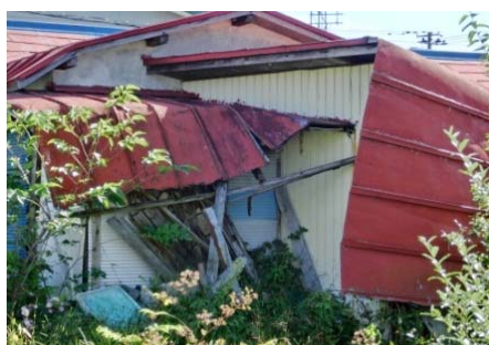
↑ 屋根が一部崩落
