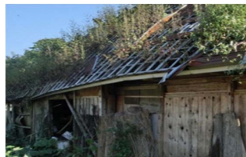
↑ 屋根が一部損壊、風で飛散のおそれ
