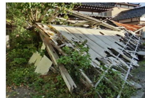
↑ 車庫部分が倒壊、隣家が近接
