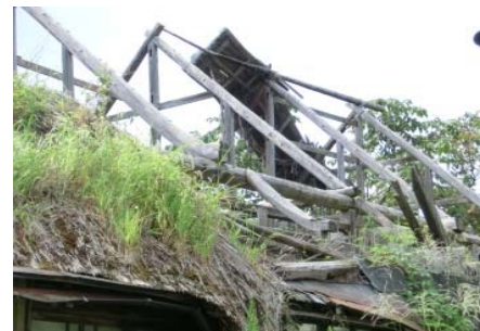
↑ 屋根が崩落、公道に面し通学路
