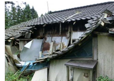
↑ 屋根が崩落、タヌキが出入り
