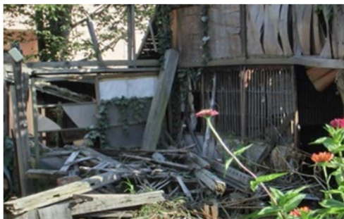
↑ 半壊した屋根材が風で隣家に飛散
