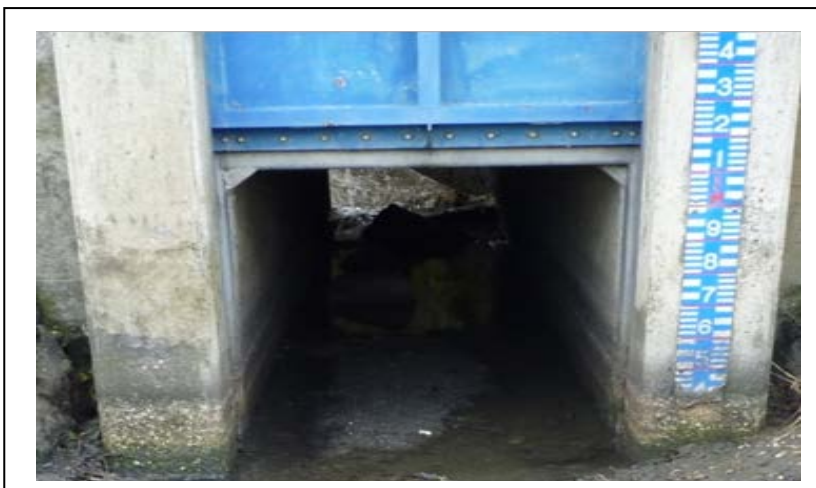
【彦山川・番田樋管】
