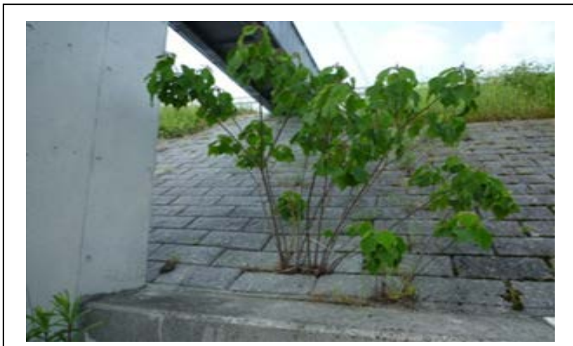
【彦山川・護岸（経塚第3排水樋管付近）】
