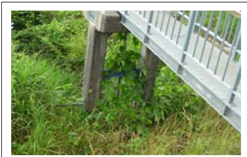
【穂波川・太郎丸排水樋管】
