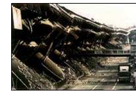
1995年阪神・淡路大震災 高速道路倒壊
