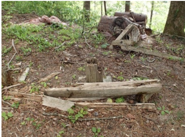
⑥ 損壊したベンチ
