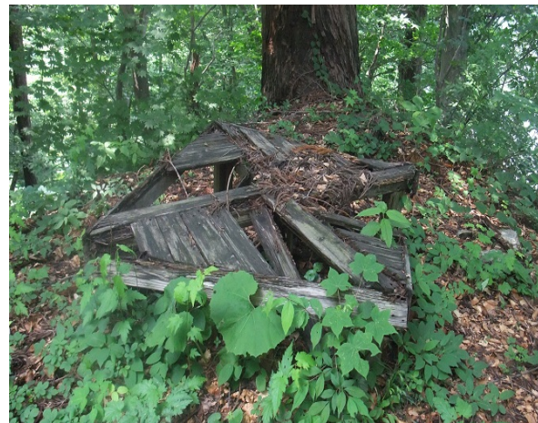
⑦ 倒壊した東屋
