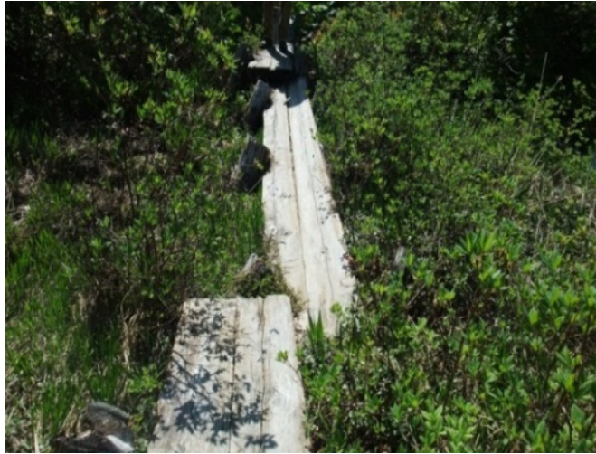
① 木道の破損
