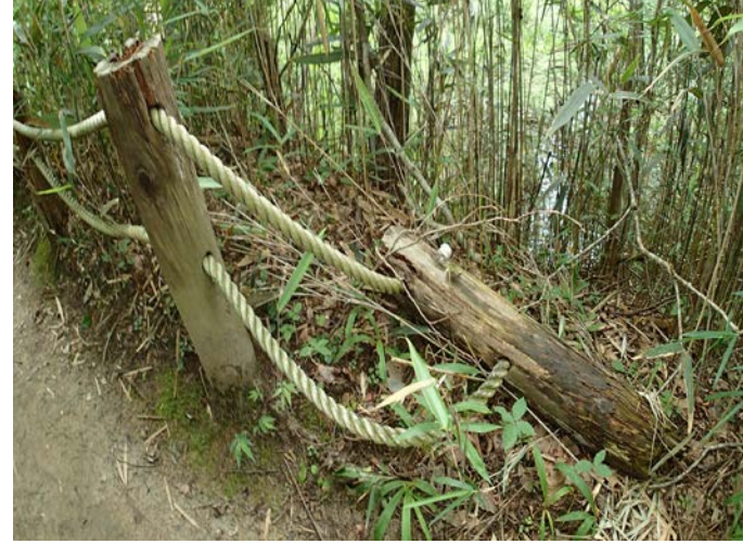
② 転落防止柵の欠損
