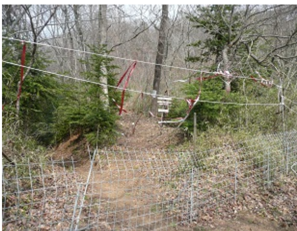
No. 7 遊歩道入口に設置されたフェンス
