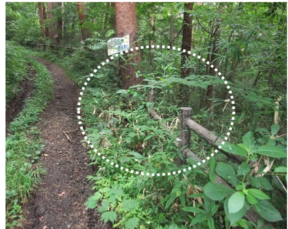
No. 6 転落防止柵の欠損
