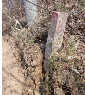
No.15 遊歩道入口の記念碑の土台が破断
