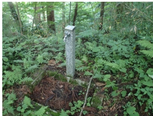
No. 4 止栓された水飲場
