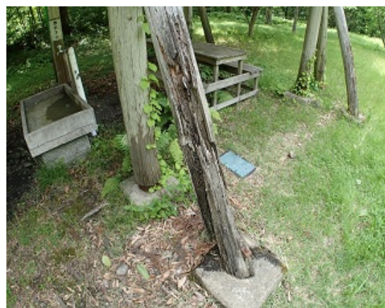
No. 6 ② 劣化した炊事棟の柱
