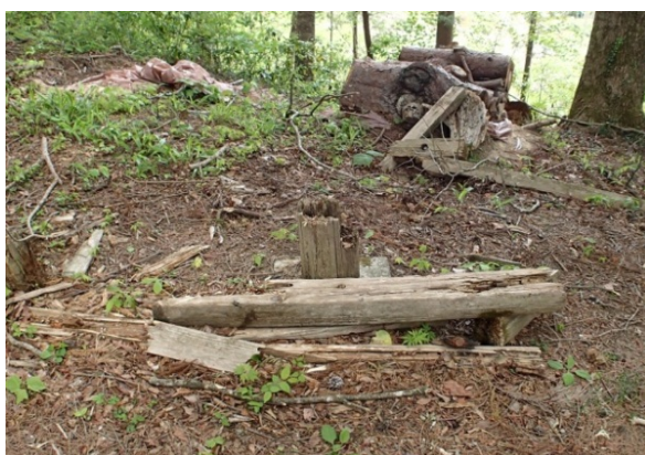
No.1 休憩施設(ベンチ)の損壊
