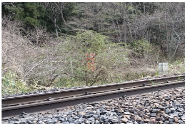
No. 9-(1) 表参道口 (鳥居の部分) の直前を通 る鉄道
