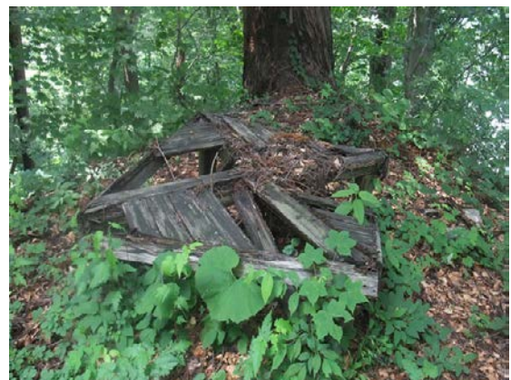
No.2 倒壊した東屋
