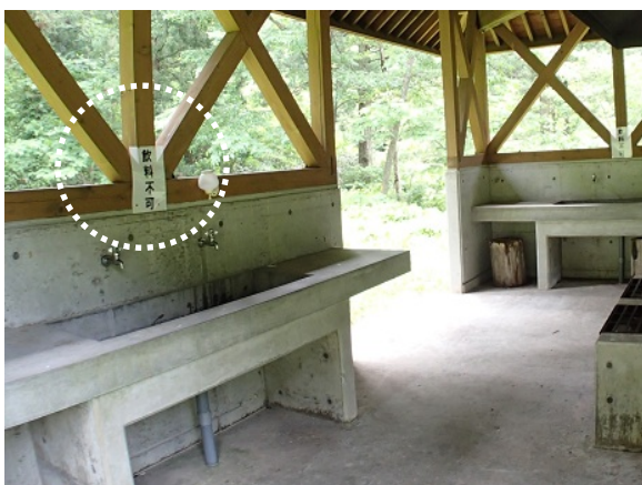
No. 6 ① 飲料不可と表示された水道
