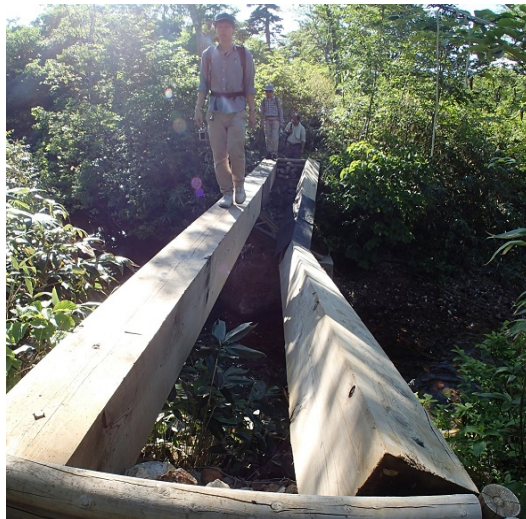
No. 3 木橋の損壊
