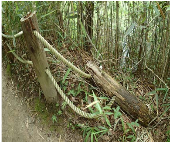
No. 5 転落防止柵の欠損
