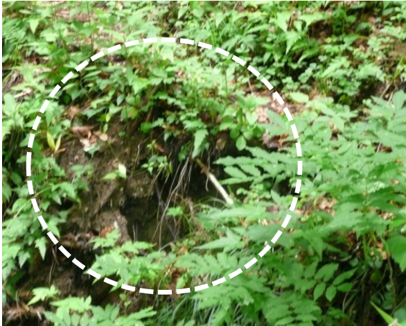
No. 1 歩道側面側の陥没
