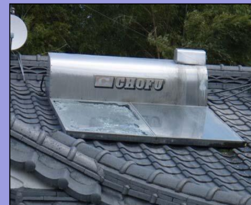
最大2cmの小さな噴石により、太陽熱温水器や太陽電池パネルが破損(火口から約9km) (霧島山新燃岳2011年噴火)
