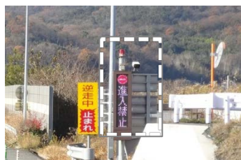
〈一部IC、休憩施設〉LED式警告標示板、赤色回転灯等
