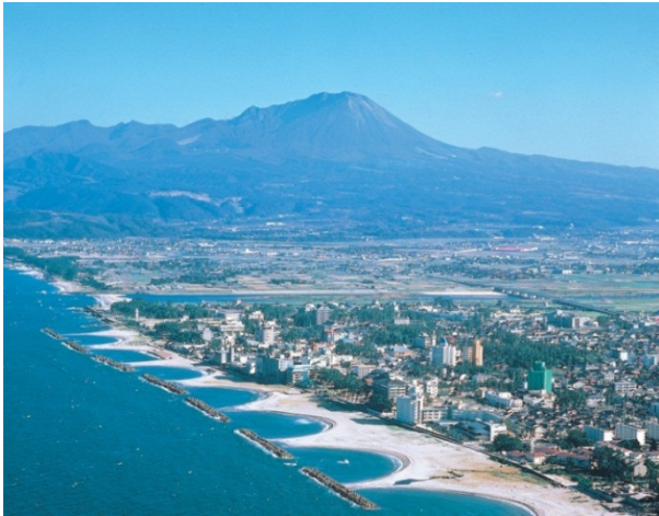
▲皆生海岸 (写真提供：鳥取県米子市)
