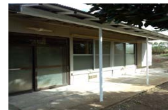
改修・清掃後
