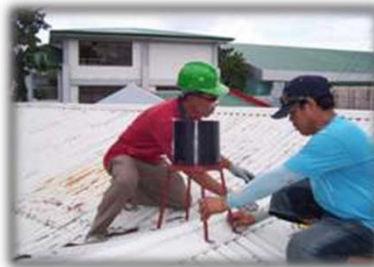
デジタル雨量観測器の設置
