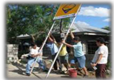
洪水標識版の設置
