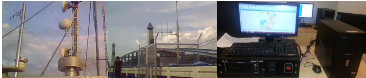
広域サイレンシステム
