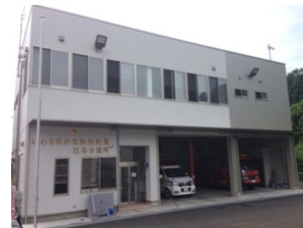
消防庁舎復旧事業 (いわき市消防本部小名浜消防署江名分遣所)
