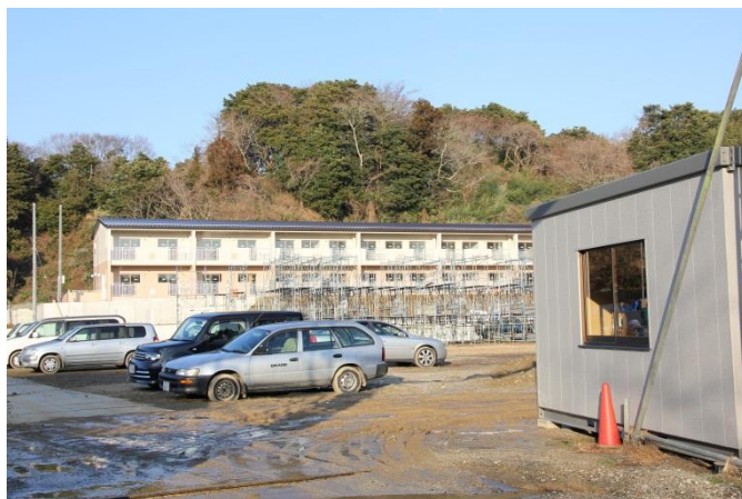
北茨城被災公営住宅
