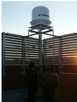
試験運用中の小型気象レーダー
