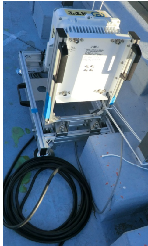
(b) 親局屋外装置設置状況
