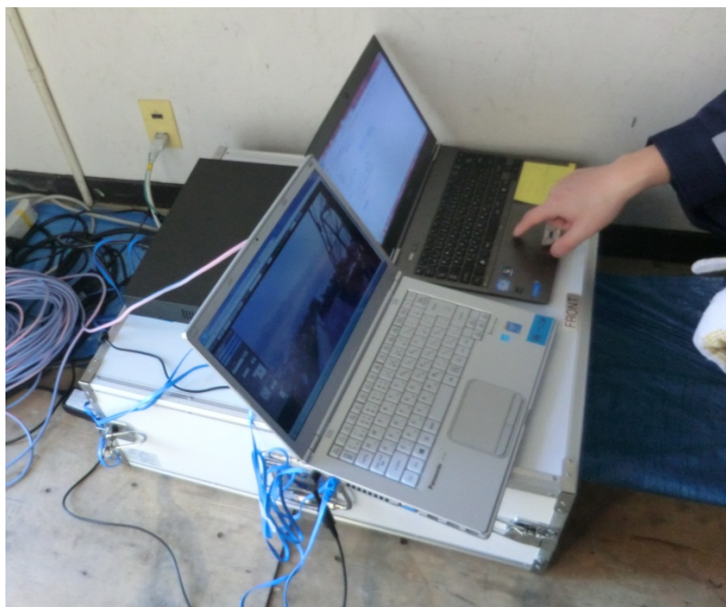
(c) 親局屋内装置設置状況
