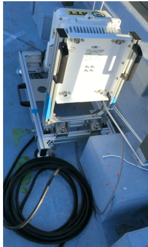
(b) 親局屋外装置設置状況
