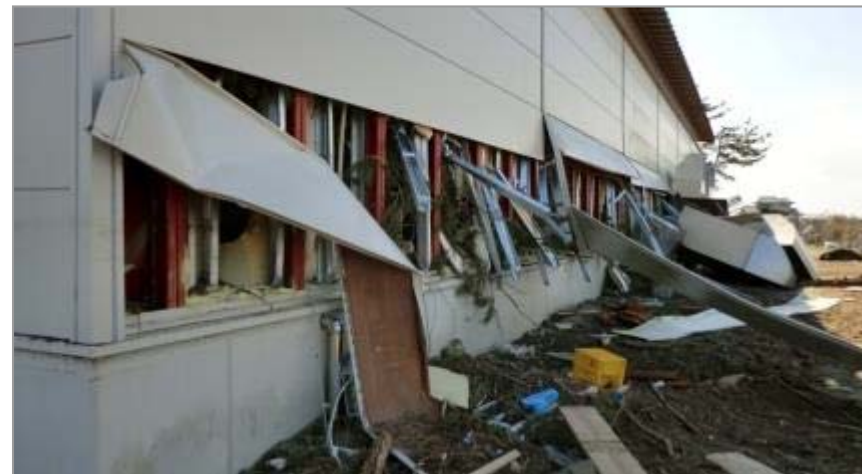
海底ケーブル陸揚局の倒壊
