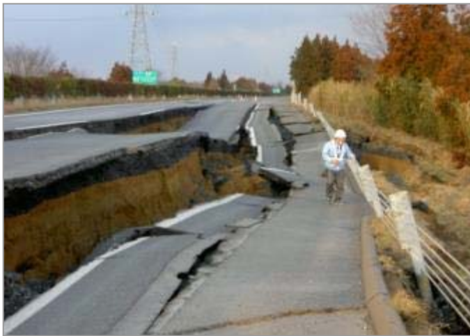
高速道路の倒壊
