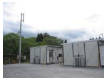
仮設住宅に新局を建設
