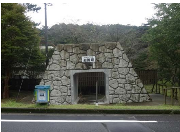
(湯之野三叉路付近)
