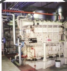
離島発電所 遠隔監視
