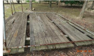
＜テントサイトの床が破損し、利用できないもの＞
