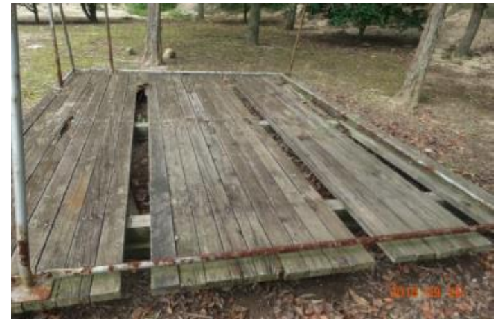
破損したテントサイト
