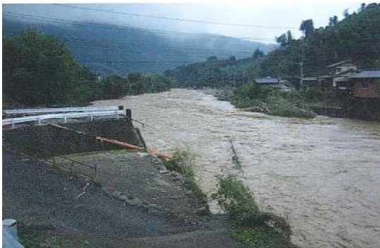
橋りょうの流失等により孤立した集落 (八女市 提供)
