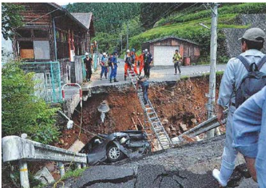
道路崩壊で孤立した集落 (うきは市 提供)
