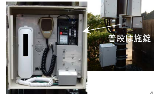
図表2 屋外拡声子局に付加された双方向通話装置
