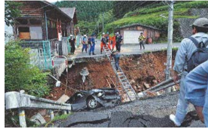
道路崩壊で孤立した集落 (うきは市 提供)
