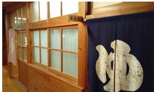
理科室を浴室に改修
