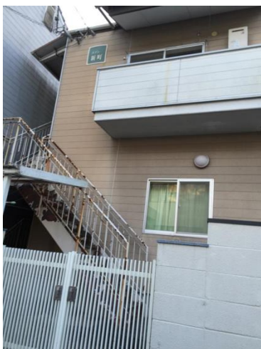
2階建て、地下に駐車場も完備
