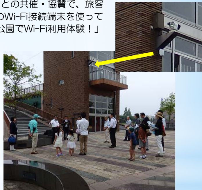
公衆無線LAN設備の説明 ※ 矢印は無線LAN設備
