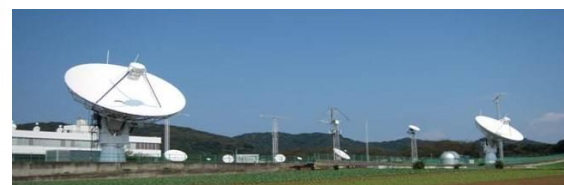
宇宙電波監視施設
