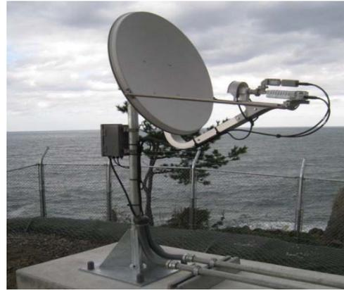
写真：固定設置型の通信端末の例（屋上や敷地にパラボラアンテナを常設）
