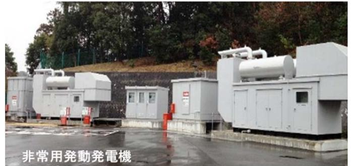
写真：衛星管制センターの非常用発電機の例
