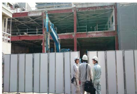
解体現場への立ち入り調査
