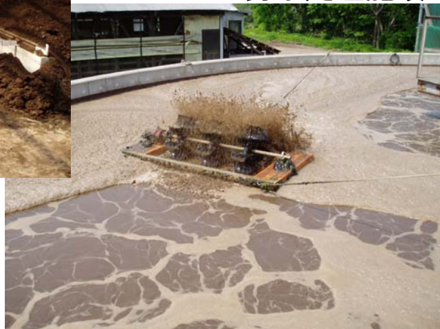
汚水処理施設
