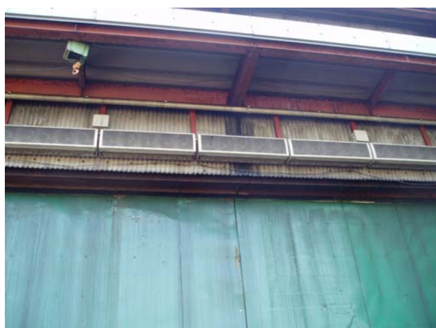
堆肥舎搬入口エアカーテン
