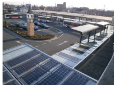
東松山駅ビル・ロータリー等に太陽光パネルを設置
