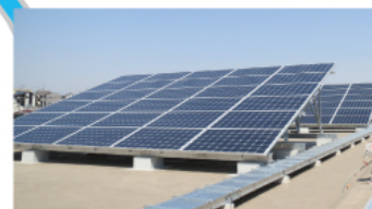
太陽光パネル (松山市民活動センター)
